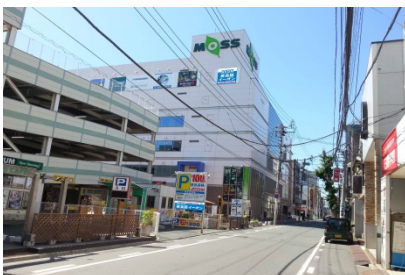
MOSS ビル 外観
